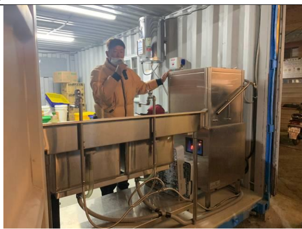
臺南復華夜市-增設餐具清洗設備
